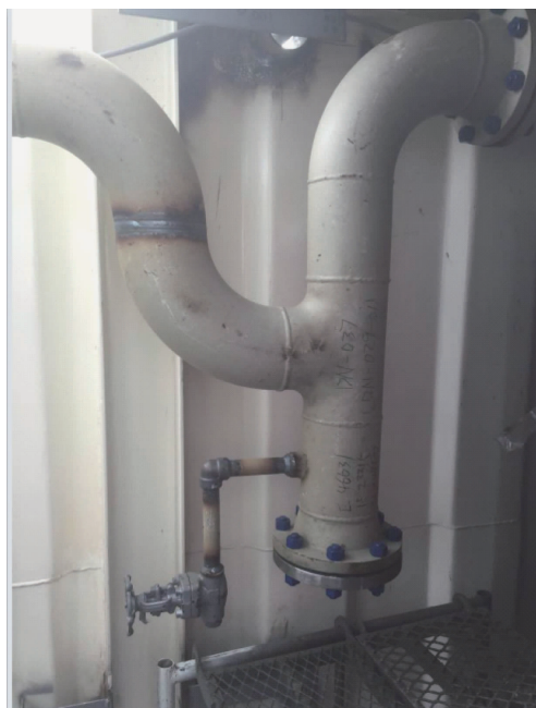
图 5 垦利 10-1 油田 WHPA/B 模块钻机新型 Y 型管液封
