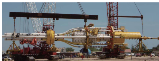
图7 集束立管底部塔形结构
