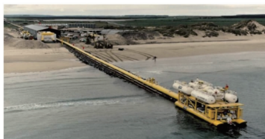
图6 集束海底管道端部管汇
