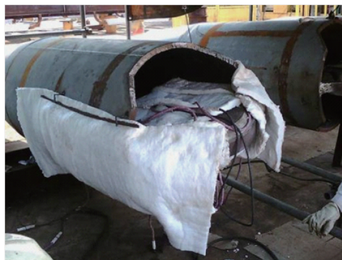
图5 焊后热处理监控
